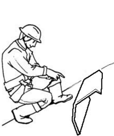
1. R型鋼板設置
