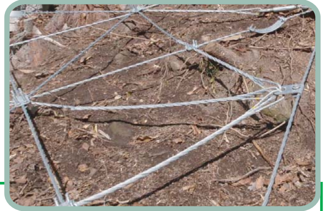
C部詳細図 (三方Aクリップ)
